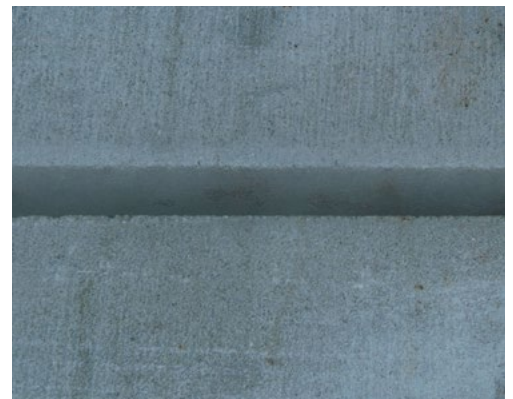
Gereinigte Fugenflanke
