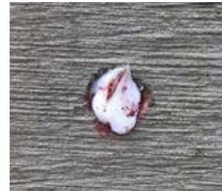
KÖSTER Crisin Creme ist standfest. Für die Anwendung aus Kartuschen und Schlauchbeuteln ist dies ein Verarbeitungsvorteil: Selbst wenn zu viel Produkt in ein Bohrloch dosiert wird, entstehen nicht gleich ablaufende „Nasen“ am Putz, die nachträglich zu dunklen Stellen führen. Das überschüssige Material kann entfernt und das Bohrloch anschließend verputzt werden.
