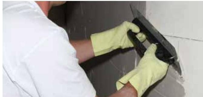
5 Anschließend wird die gesamte Fläche mit KÖSTER Hydrosilikatkleber SK abgespachtelt und geglättet.
