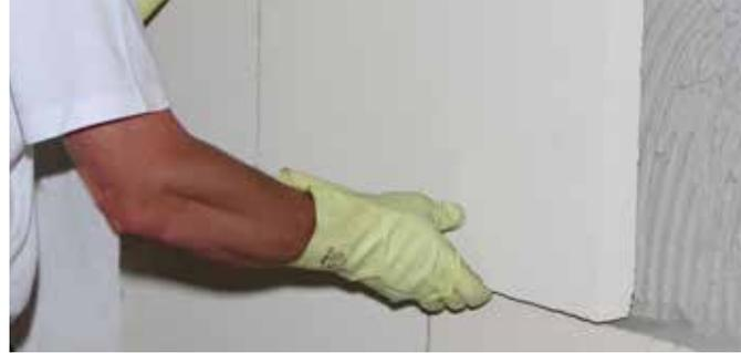
4 Die KÖSTER Hydrosilikatplatten werden nun auf die Wand gedrückt und dort ausgerichtet. Die Stöße sind ebenfalls vollfugig mit dem Kleber zu versehen.
