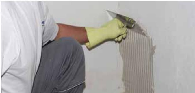
3 Der KÖSTER Hydrosilikatkleber SK ist anschließend mit einem Zahnpachtel (mind. 8 mm Zahnung) Schritt für Schritt vollflächig auf den Untergrund aufzutragen.
