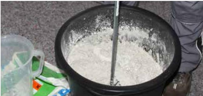
2 KÖSTER Hydrosilikatkleber SK mit ca. 5,2 Liter Wasser und einem langsam laufenden Rührwerk zu einer homogenen Masse anrühren.
